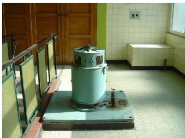
Ce projet consiste à remplacer la pompe n° 5 par une pompe de nouvelle génération (pompe immergée), afin de pouvoir gérer les haut débits d'entrée.
