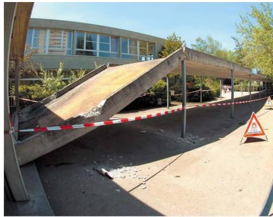
Couvert en béton datant de 1975
