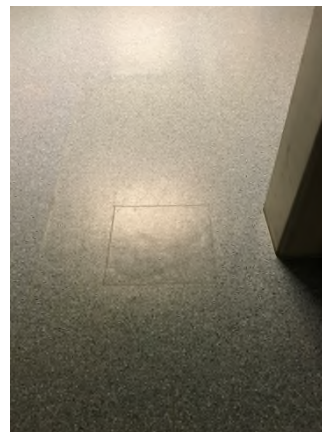
Exemple de taconnage
