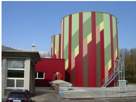
Digesteur et épaisseur-stockeur
